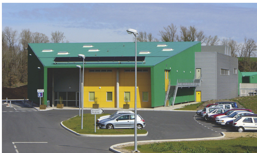
La plate-forme de valorisation des déchets ménagers de Blaye Les Mines utilise le bois pour chauffer ses locaux : centre de tri, bureaux et capte l'énergie au moyen de panneaux solaires pour produire son eau chaude sanitaire.
