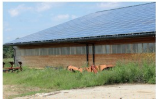
Association panneaux photovoltaïques, panneaux translucides en façade et bardage bois, dans une composition harmonieuse
